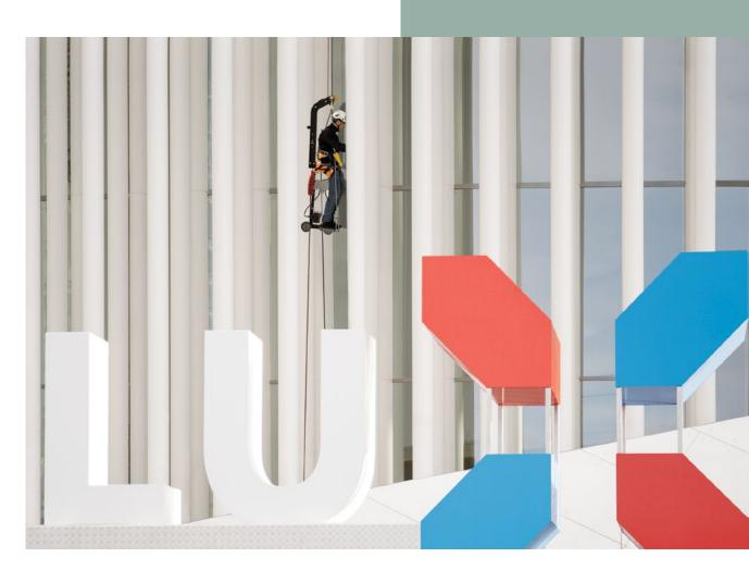
Le standing chair est un système hybride permettant à l'utilisateur de travailler aussi bien assis que debout, de sorte que l'opérateur dispose d'une large amplitude de mouvements, y compris au-dessus de sa tête. La position du treuil RopeClimber, en dessous du centre de gravité de la personne, augmente sa stabilité "en l'air". Un jeu de roues facilite son transport.
